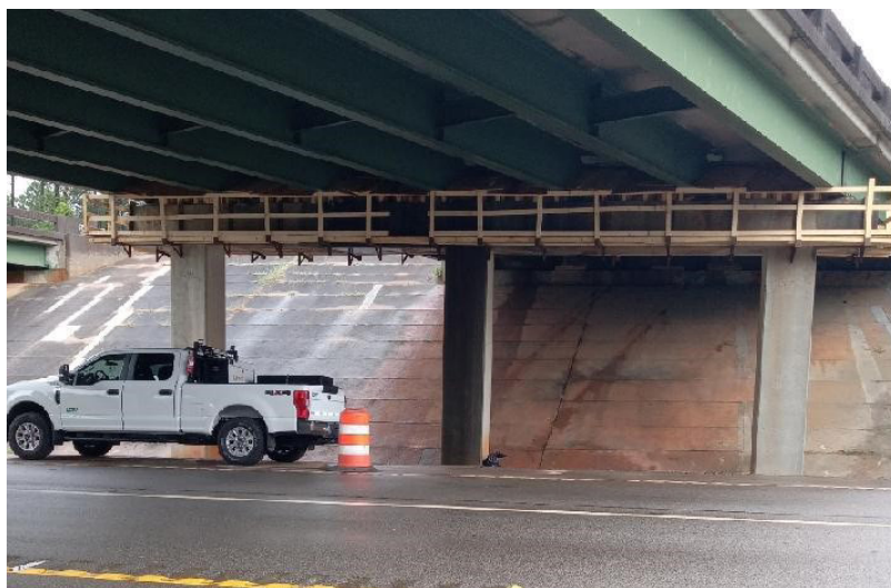
Scaffolding Edge Beam Prep
