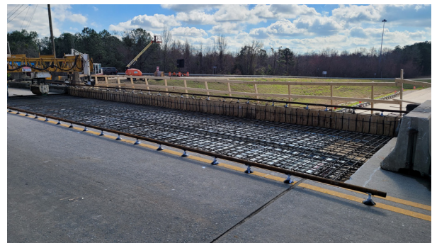
Ready For Pour
